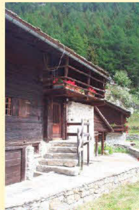
Intervento conservativo di balcone tradizionale in legno
