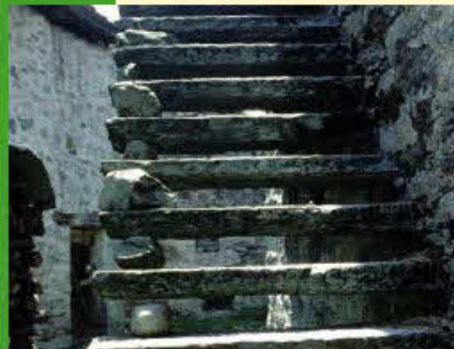
Esempio di scala esterna in pietra locale
