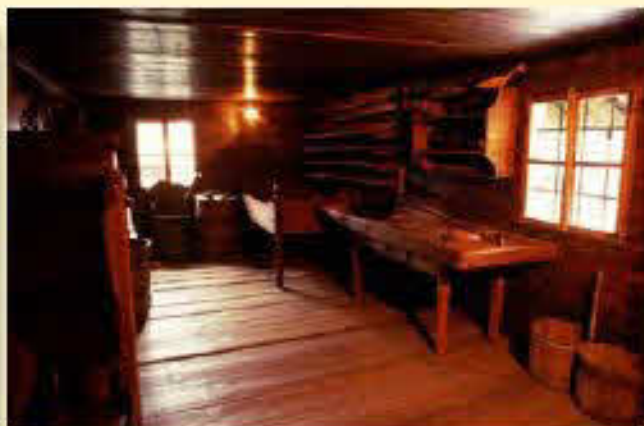
Edificio di tradizione walser con pavimento e soletta in legno
