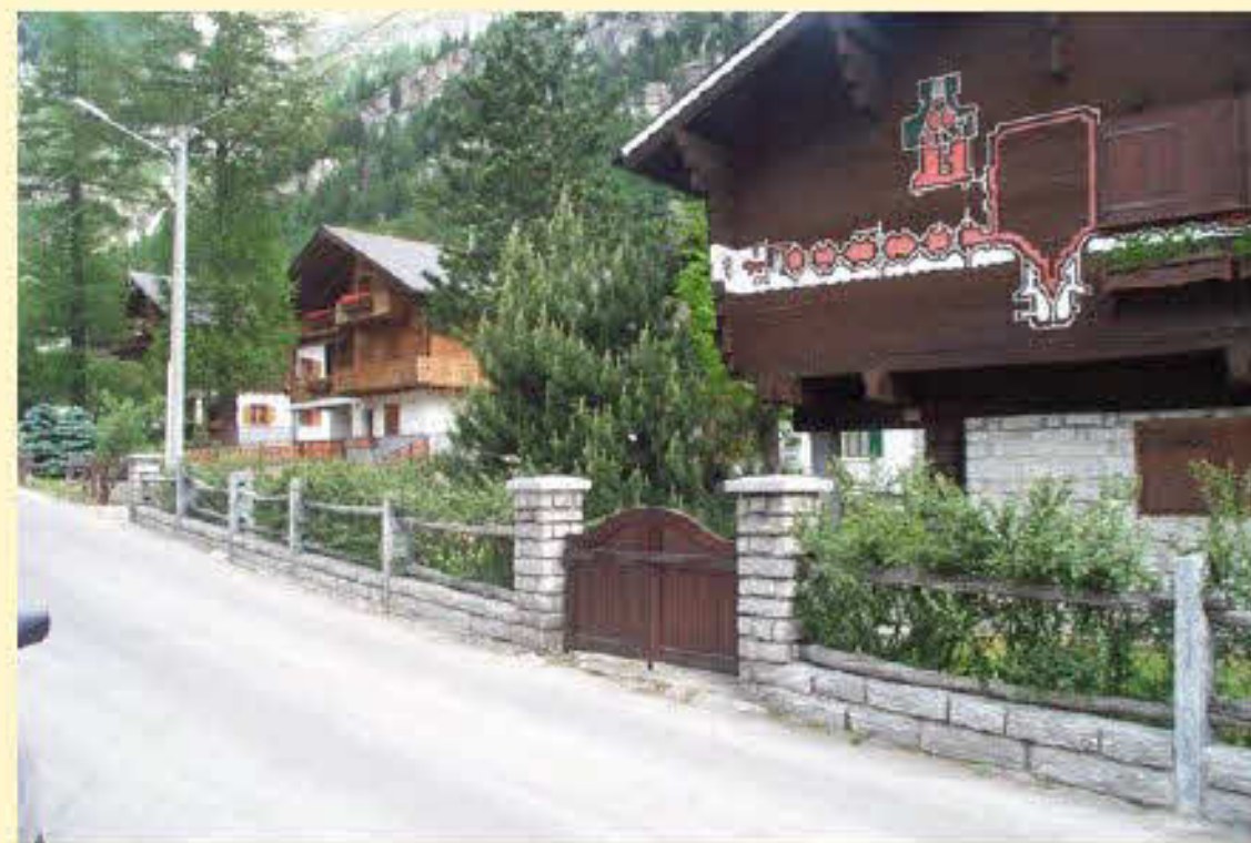
Intervento sbagliato: introduzione di cancelletto moderno su ringhiera in legno tradizionale
