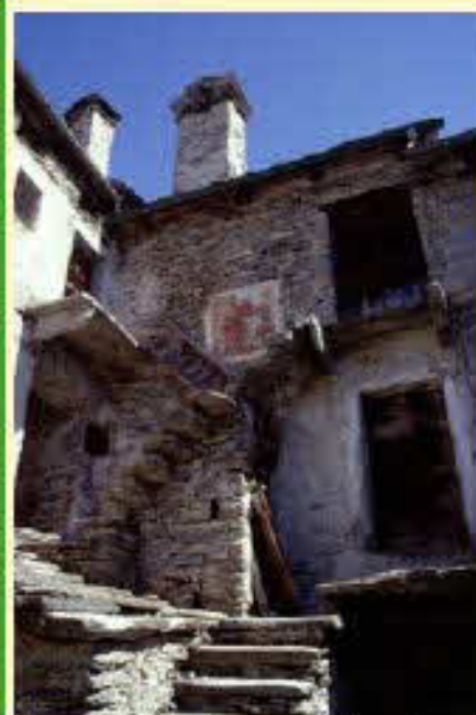
Esempio di scale rampanti in pietra
