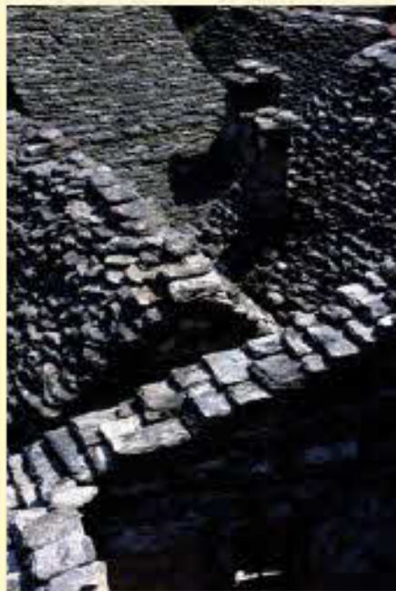
Dettaglio del raccordo tra le coperture
