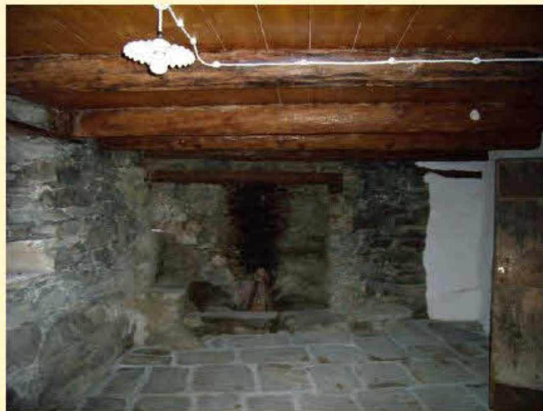
Restauro conservativo di antica cucina con camino
