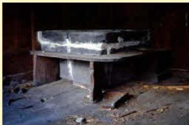
Un fornello in edificio dismesso
