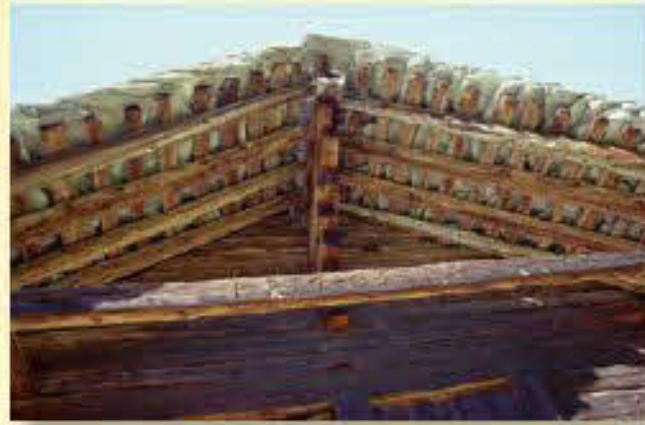
Dettaglio della struttura della copertura
