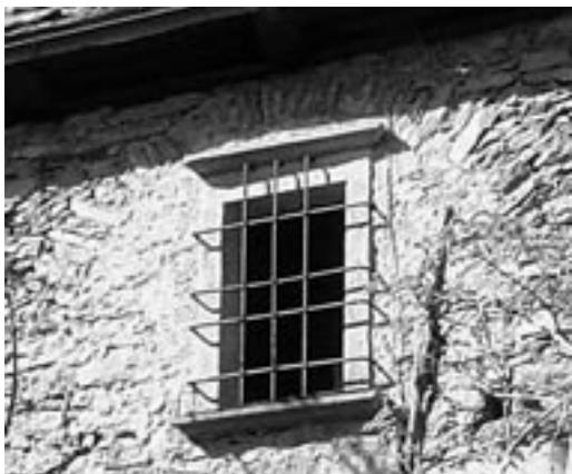
Apertura della seconda metà del secolo XVII con inferriate sporgenti; sopra l'apertura una struttura ad arco in pietra posata in verticale distribuisce meglio i carichi attorno alla stessa
