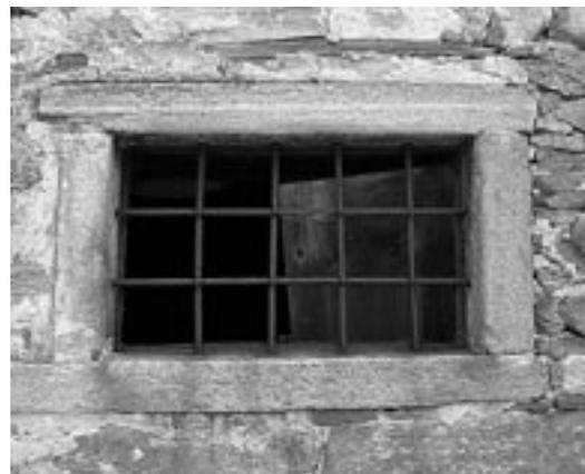
Apertura della fine del secolo XVIII con inferriate non sporgenti e non unite tramite saldatura; emerge, sopra l'apertura l'inserimento di una struttura lignea per migliorare la distribuzione dei carichi
