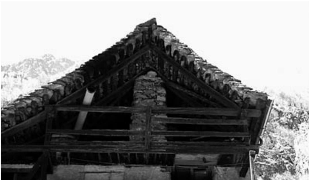
*Struttura di edificio coperto in piode*
