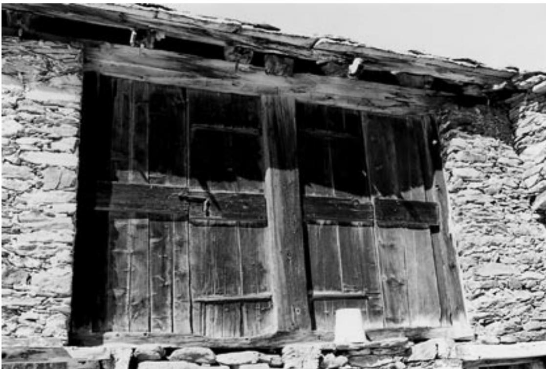
*Aperture in legno e struttura della copertura: si notino i differenti stati di conservazione*
