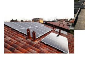
In media, per installare 1 kW – circa 3-4 pannelli – di impianto fotovoltaico su classico **tetto a falde servono 6-7 mq di superficie libera.** Su **tetto piano**, invece, lo spazio necessario è di **9-10 mq** perché bisogna tenere conto dei supporti per inclinare i pannelli.
