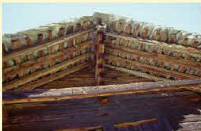
Dettaglio della struttura della copertura
