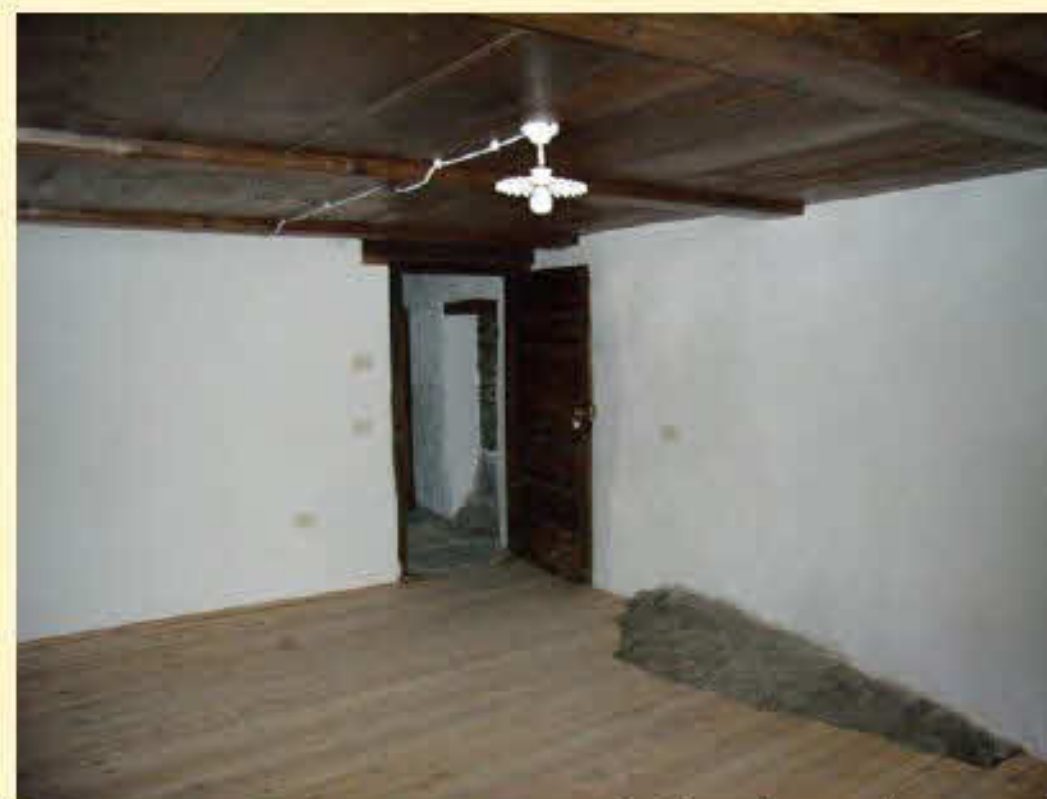
Intervento corretto, si sono restaurati i pavimenti ed i soffitti in legno avendo rispetto per la roccia affiorante
