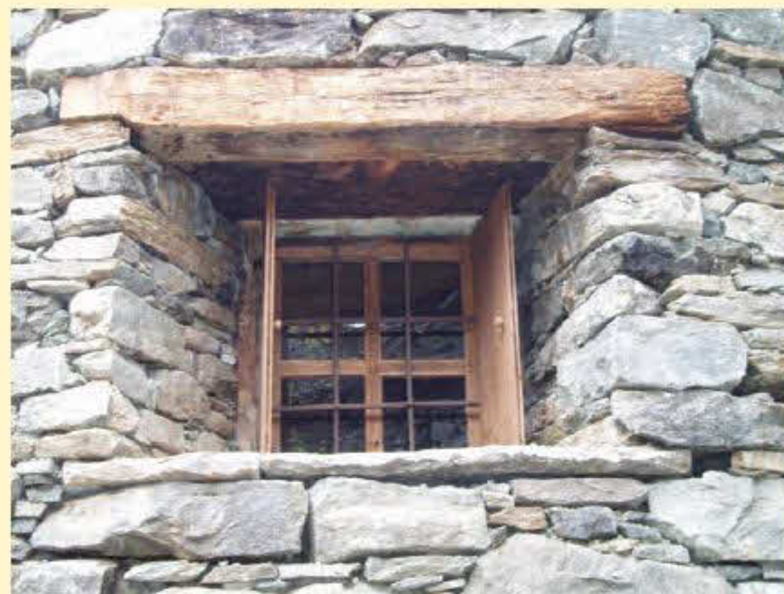
Nel restauro del serramento si è mantenuto l'architrave in legno e l'inferriata in ferro
