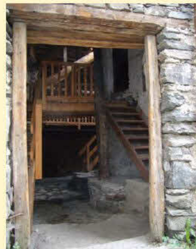
Intervento di restauro conservativo di scale in legno
