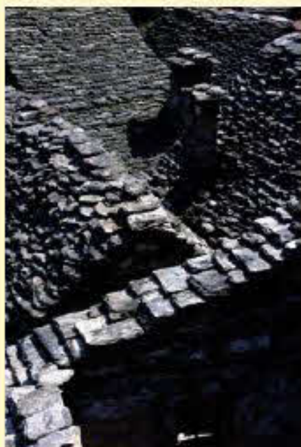
Dettaglio del raccordo tra le coperture
