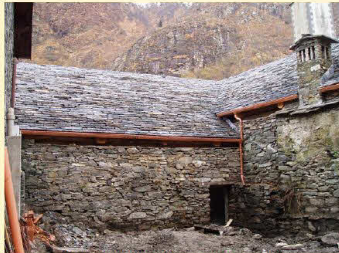
Intervento di rifacimento della copertura con pietra tradizionale
