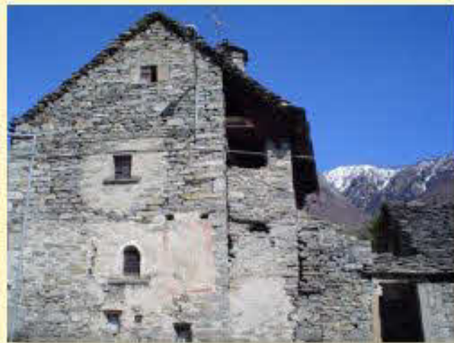
Prospetto di edificio realizzato in più corpi con porzioni intonacate
