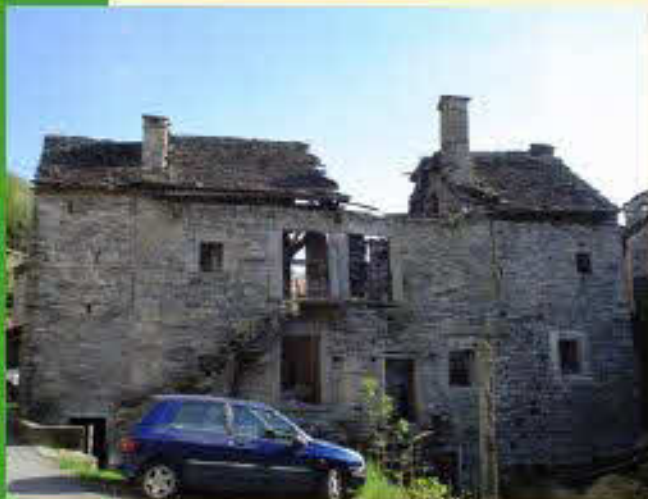
Esempio di edificio di notevole valore storico ed architettonico, si noti la complessa tessitura muraria
