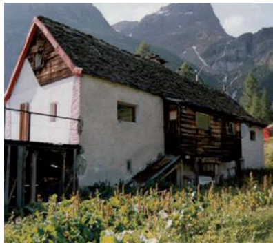
2.5-5 - Edificio prima del recupero
