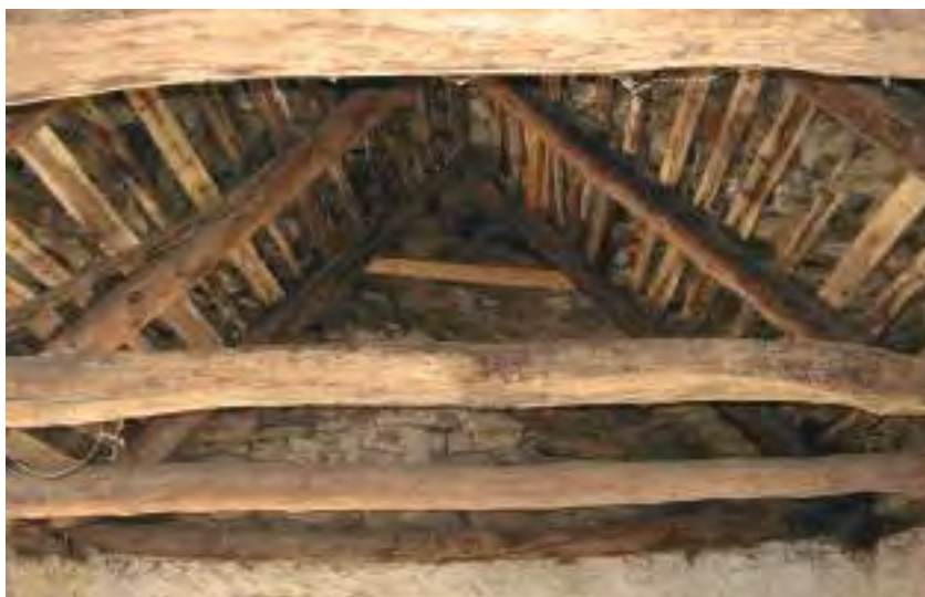
Fig. 4.2-18 - Esempio di capriata lignea che sorregge il manto di piode (Veglio).
