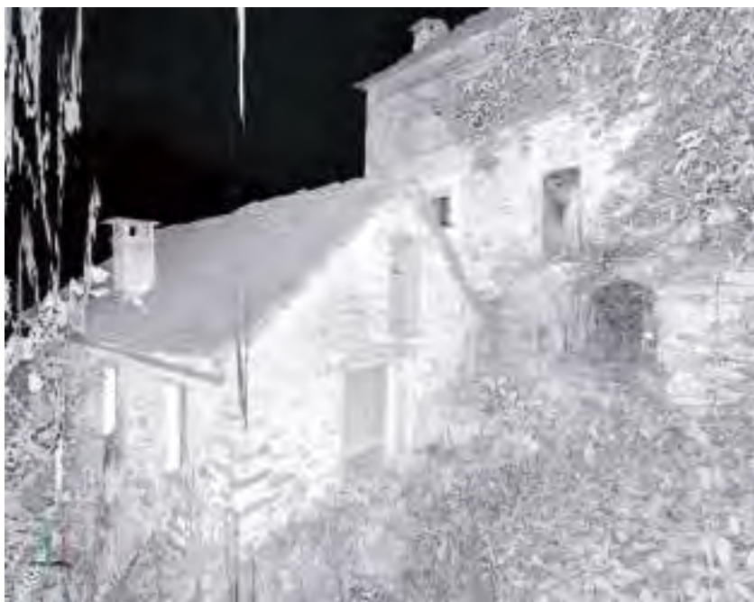
Fig. 2.4-4 - Visualizzazione di una nuvola di punti relativa ad alcune baite della frazione Veglio (comune di Montecrestese), ottenute con laser scanner FARO.
