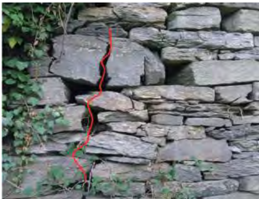
Fig. 4.2-23 - Lesione per compressione (Torre di Beura-Cardezza).
