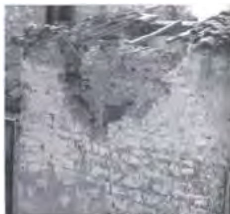
Fig. 4.2-28 - Esempio di ribaltamento sommitale di una porzione di parete generata dalle spinte e dallo sfilamento del solaio ligneo o dalla copertura sommitale.
