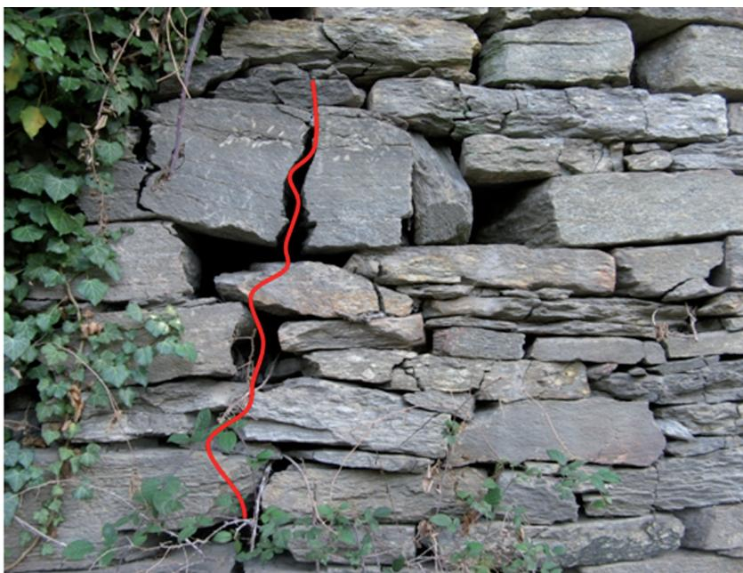
Fig. 4.2-23 - Lesione per compressione (Torre di Beura-Cardezza).
