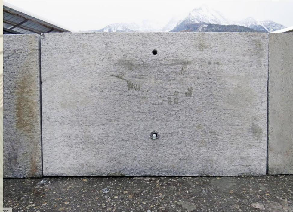
In quanto base modulare, accostata lateralmente e fissata + trasversalmente con delle barre filettate attraverso fori passanti, non idealmente presenterà delle perdite acustiche.
