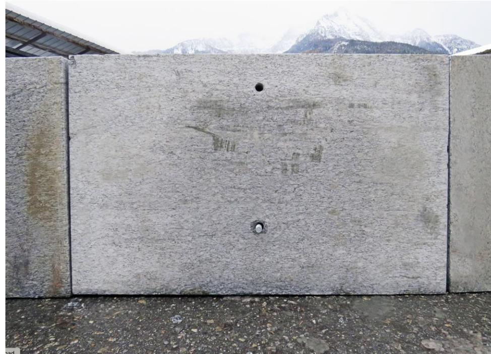
In quanto base modulare, accostata lateralmente e fissata trasversalmente con delle barre filettate attraverso fori passanti, non idealmente presenterà delle perdite acustiche.
